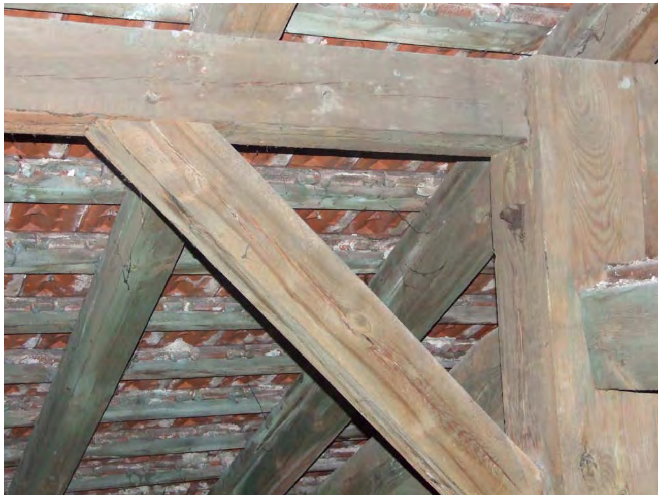
Zdjęcie nr 10. Szczegół oparcia płatwi pośredniej na mieczu i wieszaku.
