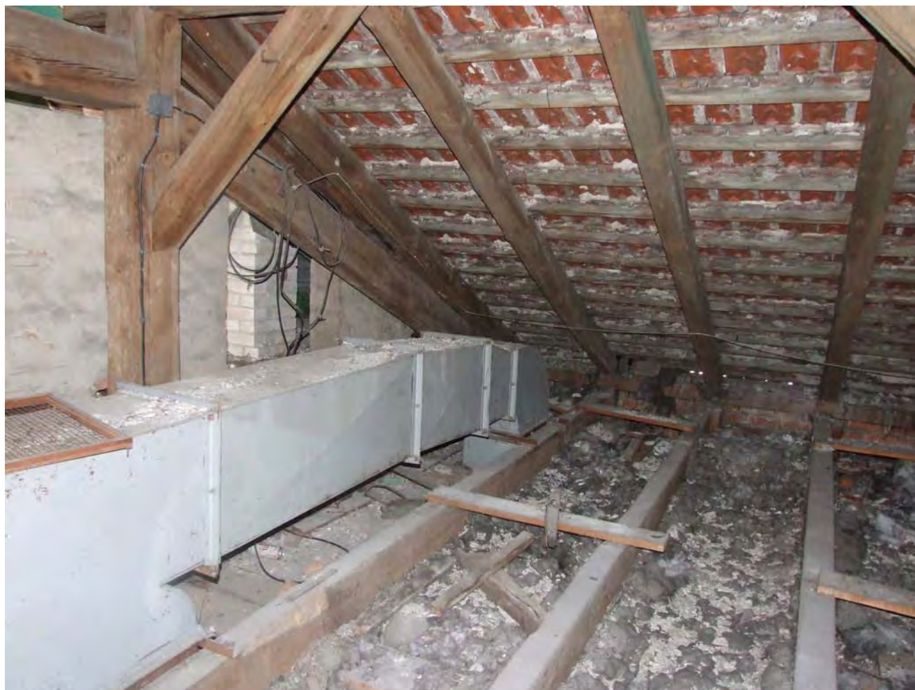
Zdjęcie nr 4. Wiązary wieszarowy od strony ściany oddzielającej segment budynku ze sceną. Wiązary skrajne posiadają pojedyncze wieszaki. Widać deski leżące poprzecznie na belkach stropu do których podwieszono wieszaki podwieszonego sufitu modułowego.
