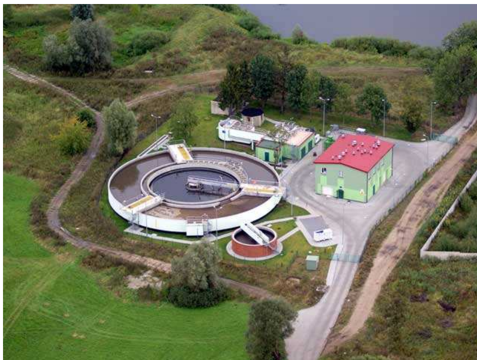
Rysunek 2. Miejska Oczyszczalnia Ścieków Skwierzyna
